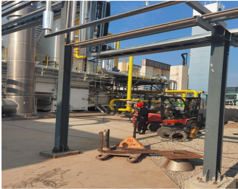
现场调查、现场采样、现场检测照片
